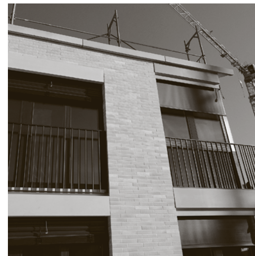
Bemusterung; Die Mockup-Fassade mit verschiedenen Varianten zur Besichtigung durch die Stadtbaukommission (20.03.2019)
