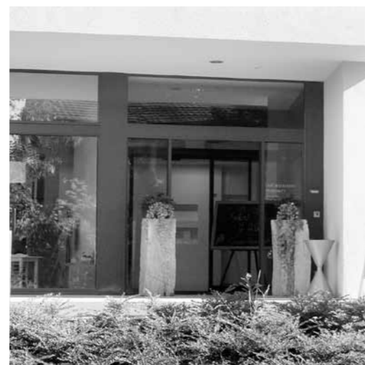
Eingang 2: Befindet sich im Erweiterungsbau und führt ins Café Restaurant und zum Mehrzweckraum. Selbstverständlich sind alle Häuser intern miteinander verbunden und durch eine gute Orientierungshilfe findet man sich gut zurecht.
