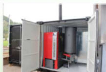
Wärmeerzeuger Pellet- / Hackschnitzelofen
